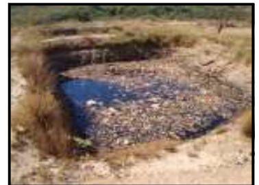
Lagoa de tratamento não apresenta sistema de impermeabilização
