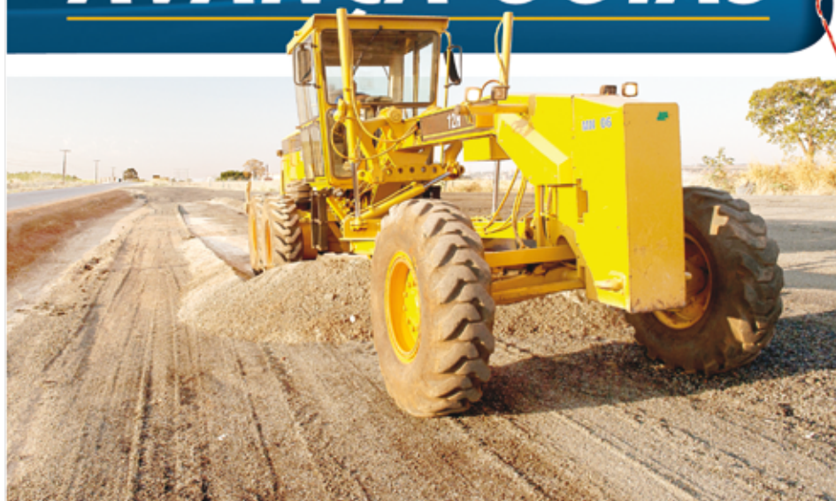
Máquinas do Programa Rodovia Reconstruir trabalham na GO-174, em Rio Verde
