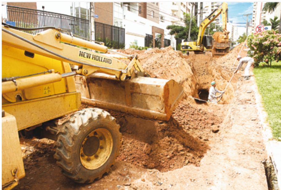
Obras do Interceptor Vaca Brava: ampliação da captação de esgoto e despoluição
