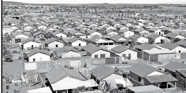
Moradias no Real Conquista com sistema de aquecimento por energia solar
