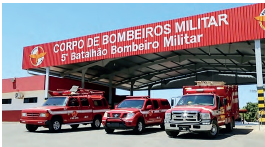
A acomodação da base vai possibilitar uma prestação de serviço mais rápido
