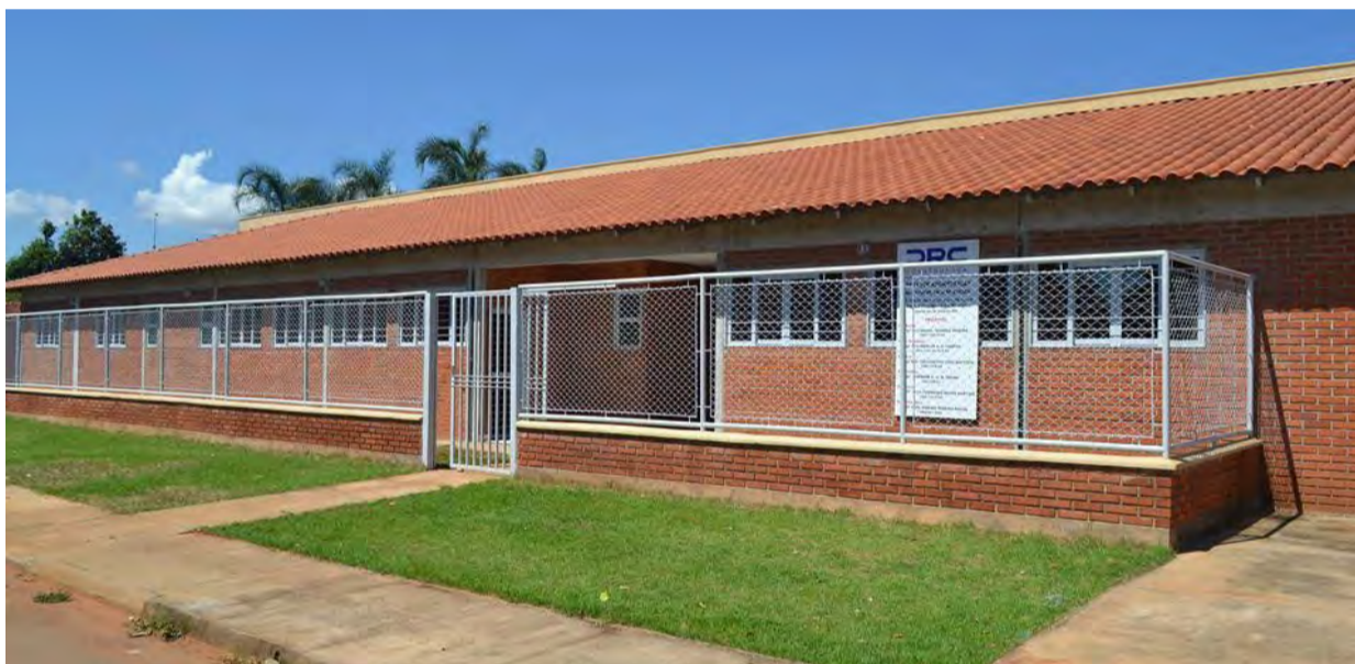
Creche Anjos da Guarda. Obra Dom Orione
