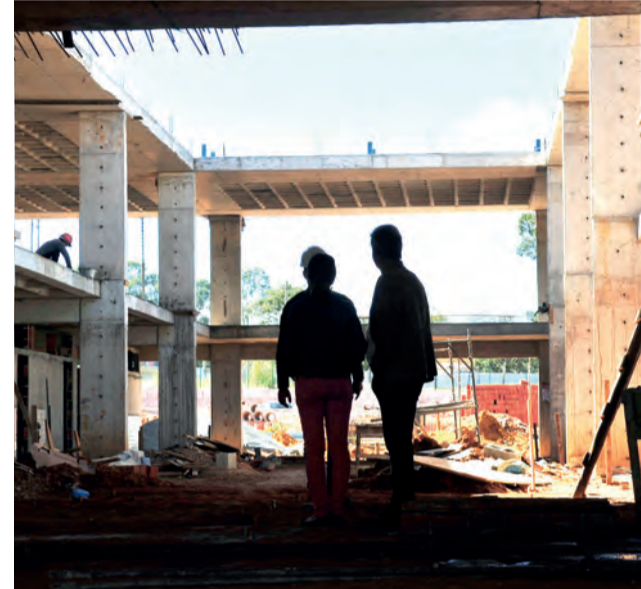
Obras aumentarão quantidade de salas de aula e banheiros
