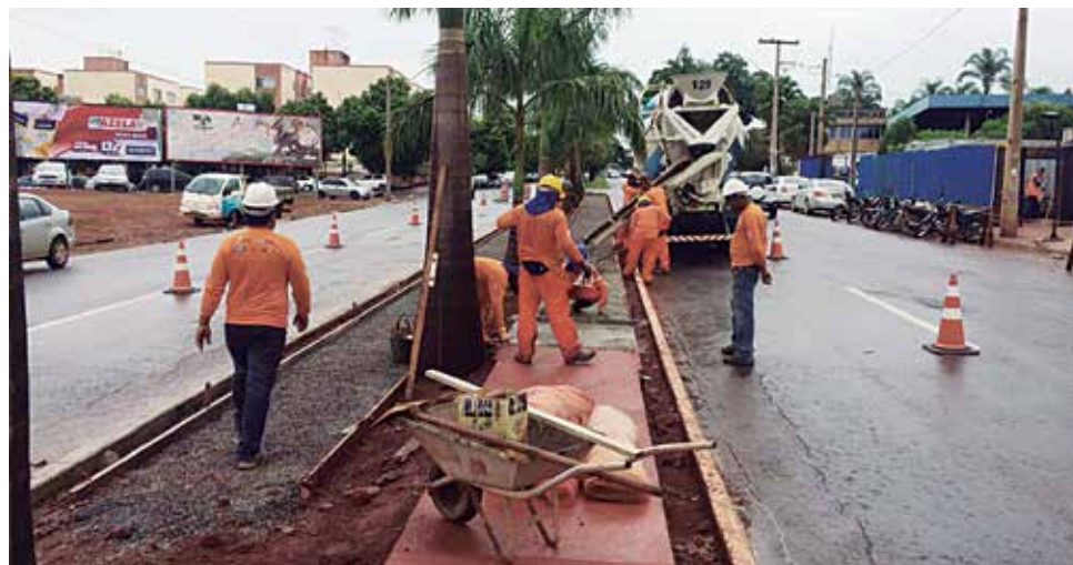
Ciclovias é executada e faz parte do corredor preferência de ônibus T-7
