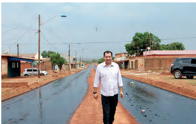
Prefeito Hildo do Candango vistoriando obras em Águas Lindas de Goiás
