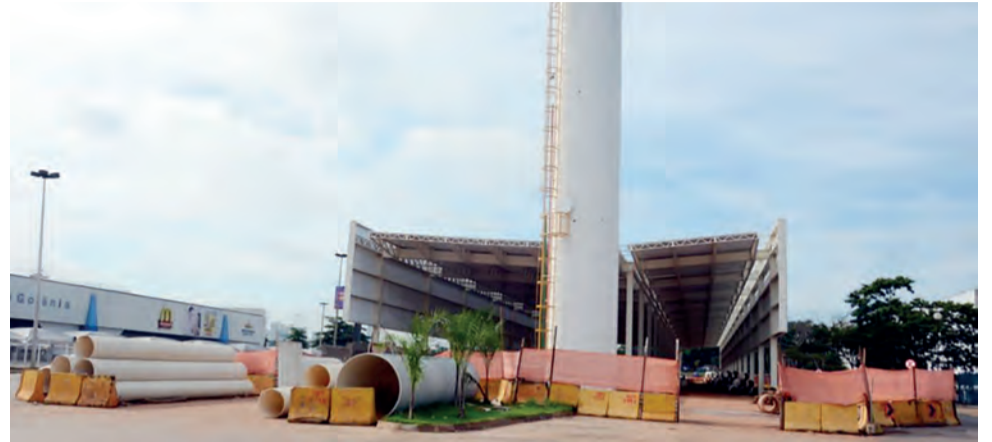
Terminal Rodoviária, do BRT, poderá ter movimentação diária de 12 mil pessoas em Goiânia
